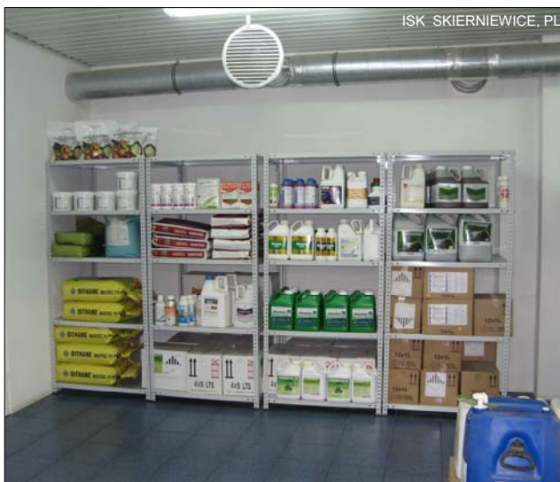
Rys. 6 Magazyn powinien być wyposażony w sztuczne oświetlenie, wentylację i półki z materiału nienasiąkliwego, Posadzka powinna być nienasiąkliwa i łatwo zmywalna. W wydzielonym miejscu powinny znajdować się pojemniki na skażone odpady oraz na puste opakowania po środkach ochrony roślin
