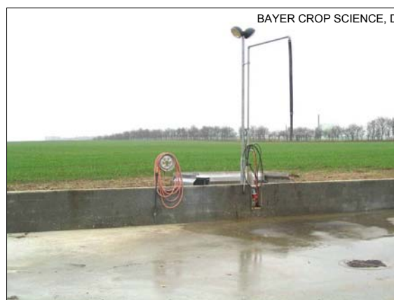
Rys. 13 W gospodarstwie ciecz użytkową należy sporządzać na nieprzepuszczalnym podłożu, umożliwiającym zbieranie skażonej wody
